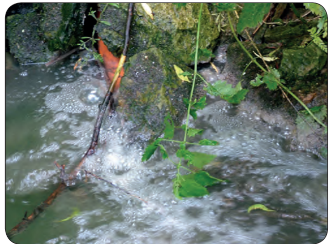
Nielegalny wylot ścieków
