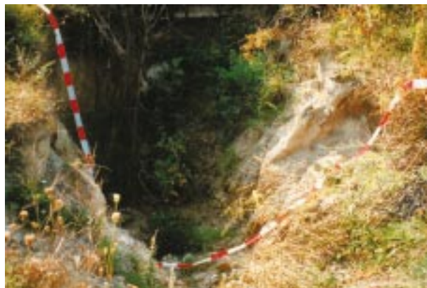
Szkody górnicze po kopalni fosforytów na terenie Annapola Fot. Jan Zawiślak
