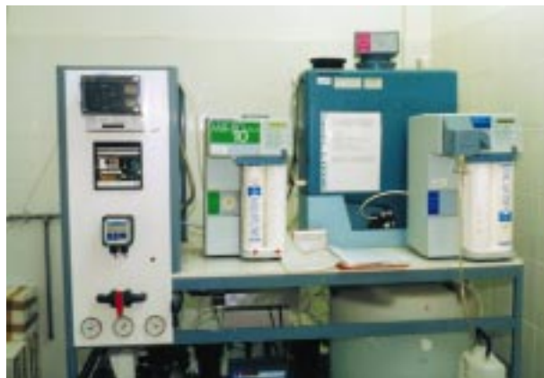
Stacja dejonizacji wody RIMCO
